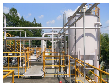
排水処理設備（板倉工場）
