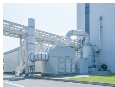
脱臭設備（板倉工場）
