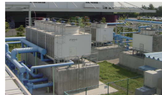
水循環設備 (板倉工場)
