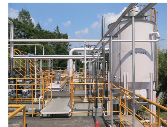
排水処理施設（板倉工場）
