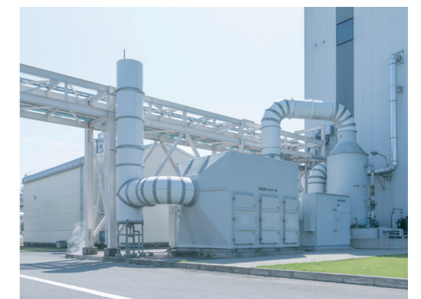
脱臭設備（板倉工場）
